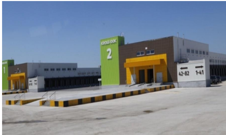
Казахстан, г. Караганда, Распределительный центр Наружные блоки: 20 шт. Внутренние блоки: 109 шт.
