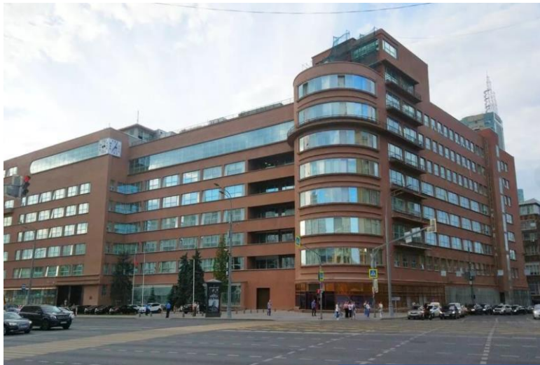
Россия, г. Москва, Министерство сельского хозяйства РФ Наружные блоки: 112 шт. Внутренние блоки: 1300 шт.
